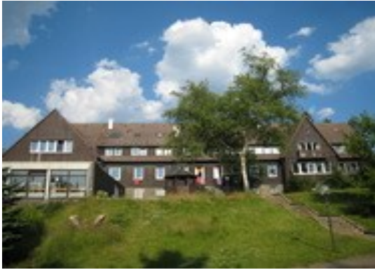
Haupthaus von außen
